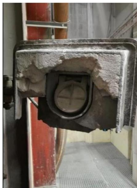
Figure 4 : Porte d'accès cassée en deux à cause de l'explosion
