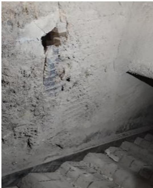
Figure 13 : La projection d'un fragment de bouteille de protoxyde d'azote dans le four
