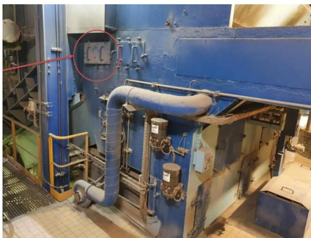
Figure 10 : Trappe qui a sauté sous le souffle de l'explosion
